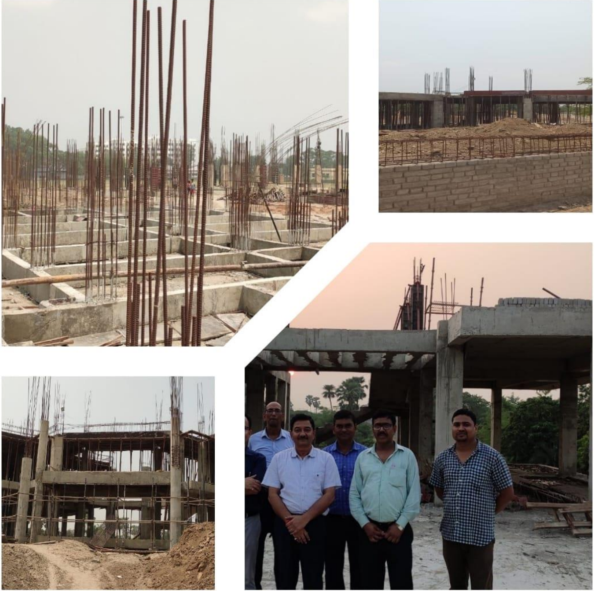
चित्र: माननीय निदेशक द्वारा वर्तमान निर्माण कार्य का निरीक्षण Figure: Inspection of current construction work by Honorable Director
