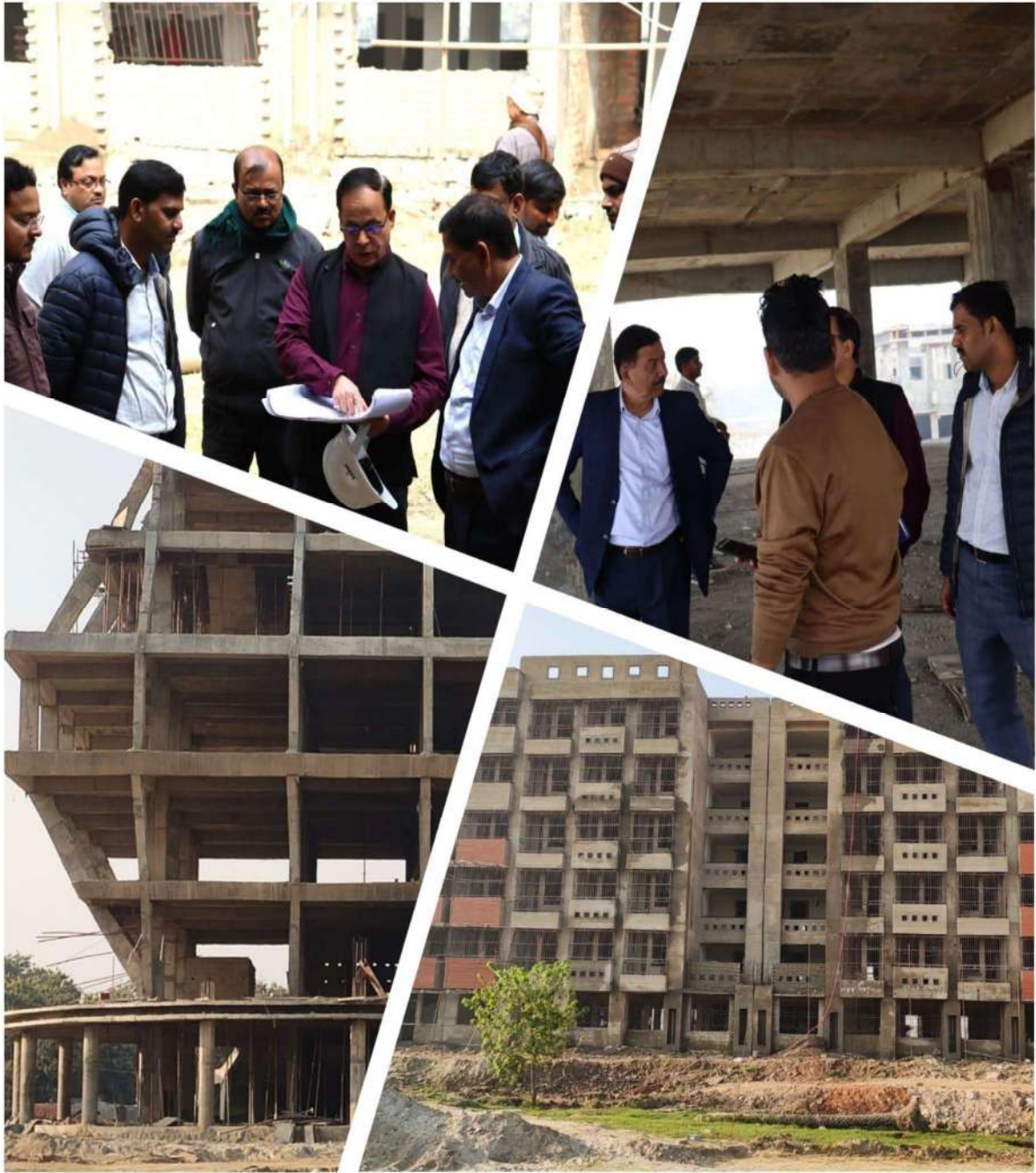
चित्र: माननीय निदेशक द्वारा वर्तमान निर्माण कार्य का निरीक्षण Figure: Inspection of current construction work by Honorable Director
