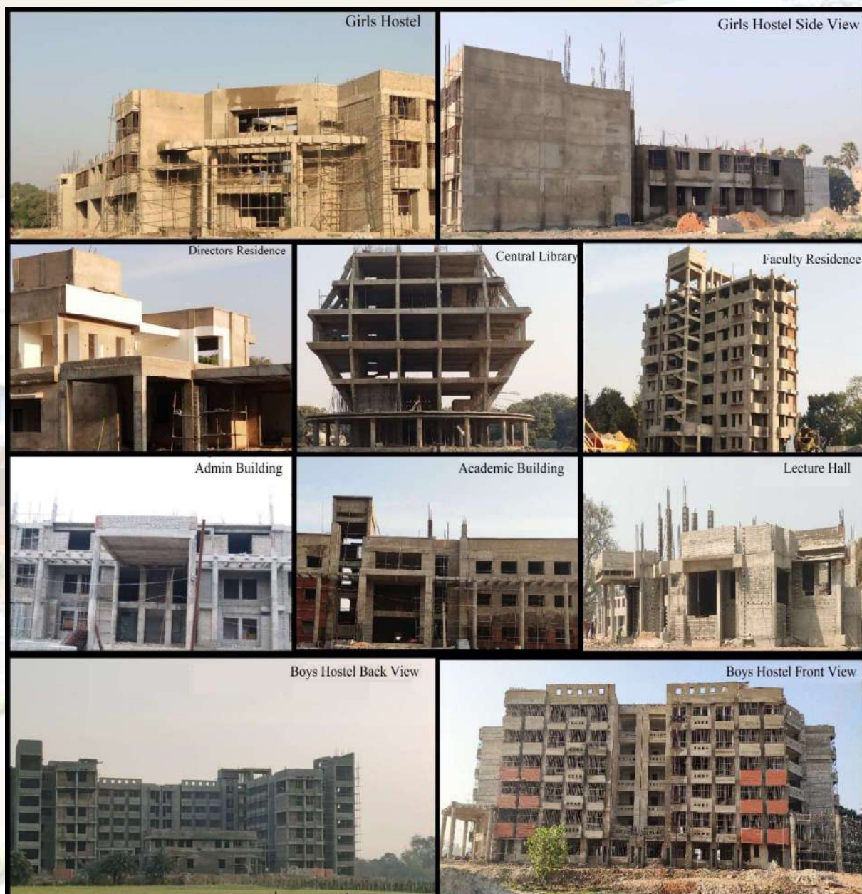
चित्र: विभिन्न भवनों के निर्माण कार्यों की वर्तमान स्थिति Picture: Current status of the construction works of the various buildings
