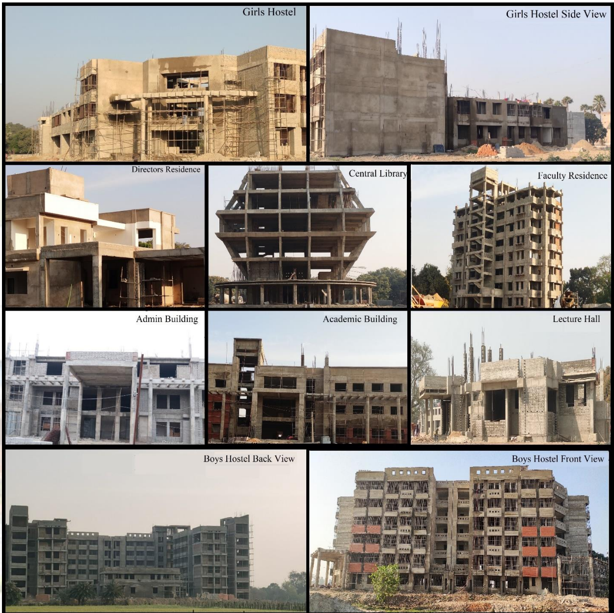
चित्र: विभिन्न भवनों के निर्माण कार्यों की वर्तमान स्थिति Figure: Current status of the construction works of the various buildings
